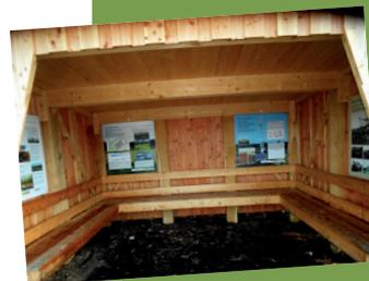
Der Unterstand besteht aus einem Gerüst aus Eichenbalken und einer Verkleidung aus Lärchenholz. Das Dach ist begrünt.
