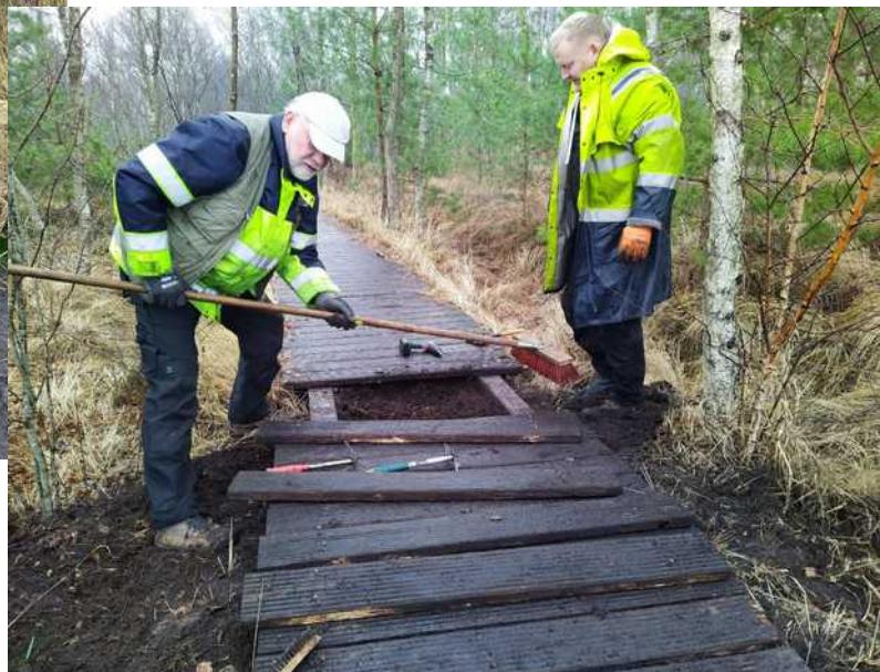
Stephan schraubt die Bretter ab, dann wird die Erde von Ingo und Stephan entfernt, Ich habe neben dem Fotografieren die Bretter von unten und oben abgebürstet. Ausrichten und anschrauben, fertig.....
